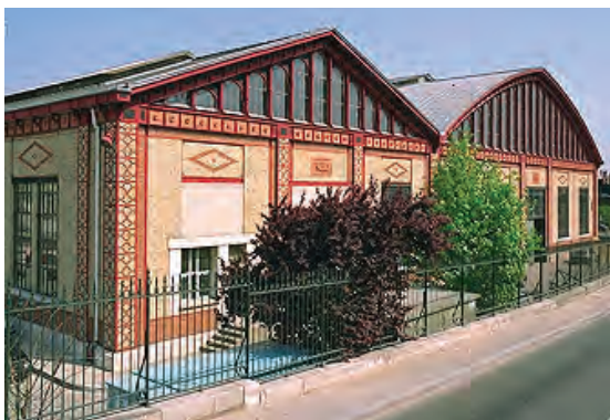
Usine des eaux
