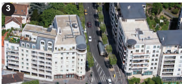
Avenue Barbusse - Pont de la Puce
