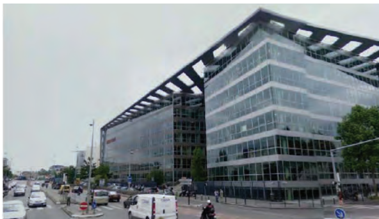
Avenue Charles de Gaulle : immeuble « Oracle » (pôle tertiaire au sud-ouest)
