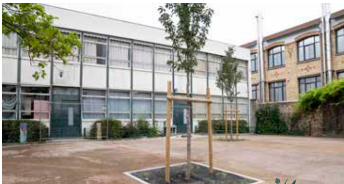
► La cour de la maternelle Reine-Henriette dispose désormais de nouveaux arbres et d'un revêtement drainant qui n'emmagasine plus la chaleur. Photo Alexis Goudreau
