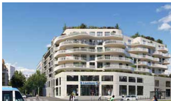
Le futur centre commercial Leclerc, situé au pied du tramway, à l'angle de l'avenue de Stalingrad et de la rue Jules-Michelet.
